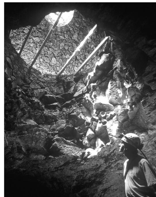
Jameo artificial (abierto tras un replanteo topográfico mediante teodolito) para dar acceso desde la bodega de la vivienda al tubo volcánico. En la imagen, F. Rguez., Arquitecto a cargo del proyecto.
