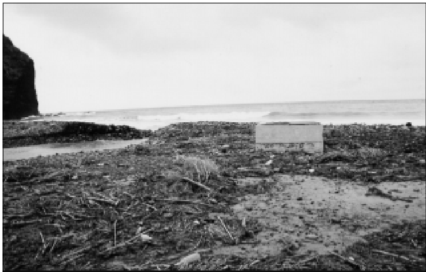
Pozo de captación tras la inundación de 23 de diciembre de 2001.
