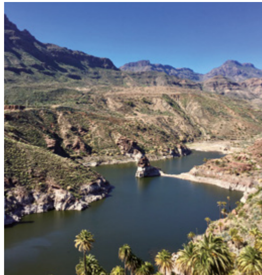
Presa de la Sorrueda.
