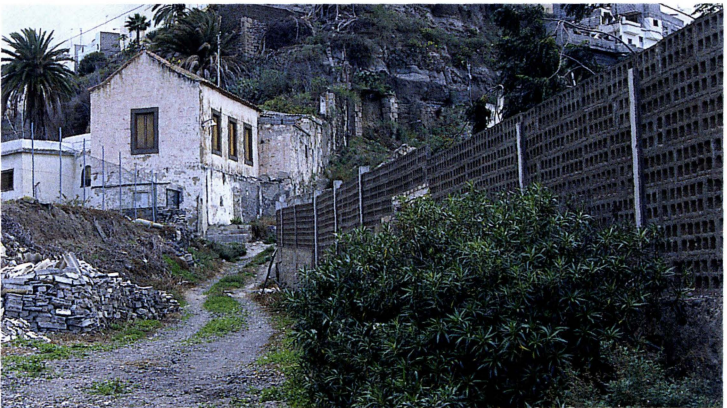
Acceso desde el cauce del Guiniguada al Lomo Verdejo y Barranco de Los Toledo.
