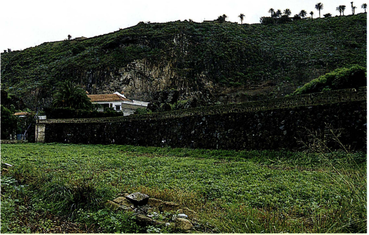
Muro de piedra seca levantado con las escorias del malpaís, durante el siglo XIX.
