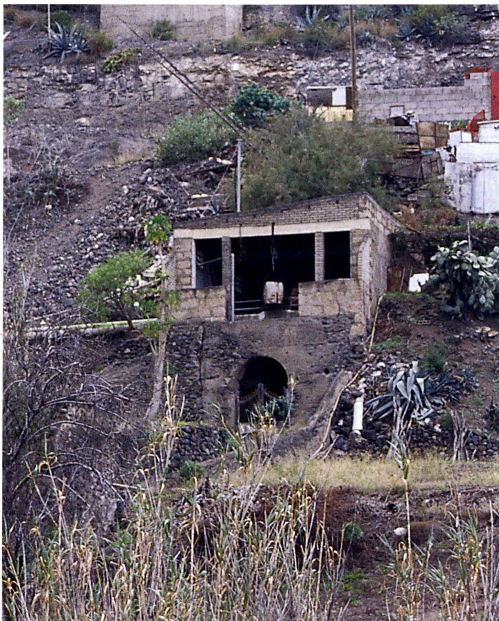
Pozo situado en las inmediaciones de Albiturria, bajo el viaducto.
