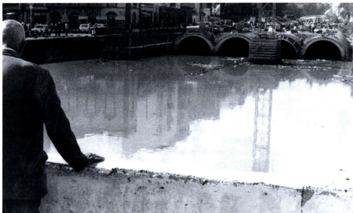
Obras de canalización del tramo final del Barranco Guiniguada bajo la futura carretera G.C.-811 a principios de los 70, s. XX.
