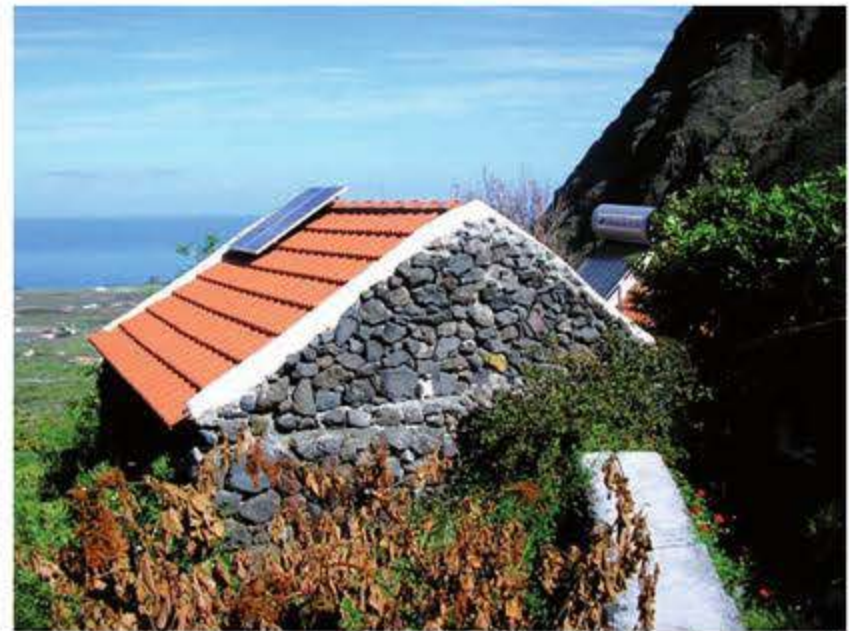
Instalación fotovoltaica aislada
