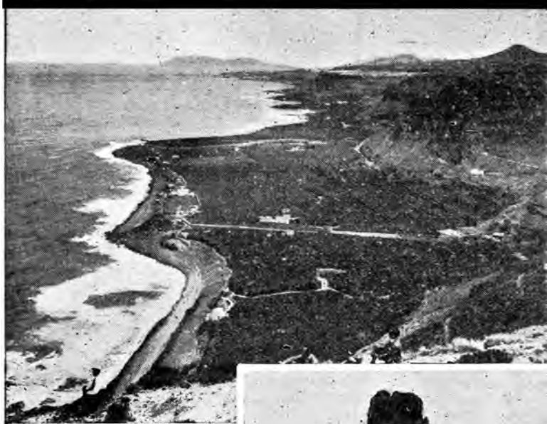
La costa de Bañaderos La côte aux Bañaderos
