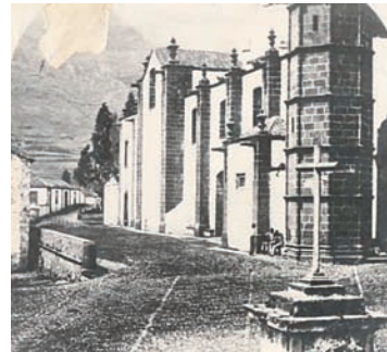
■ Vista de la zona izquierda del templo. Puede observarse el muro que salvaba el desnivel con la calle Obispo Marquina, desaparecido en 1890.
