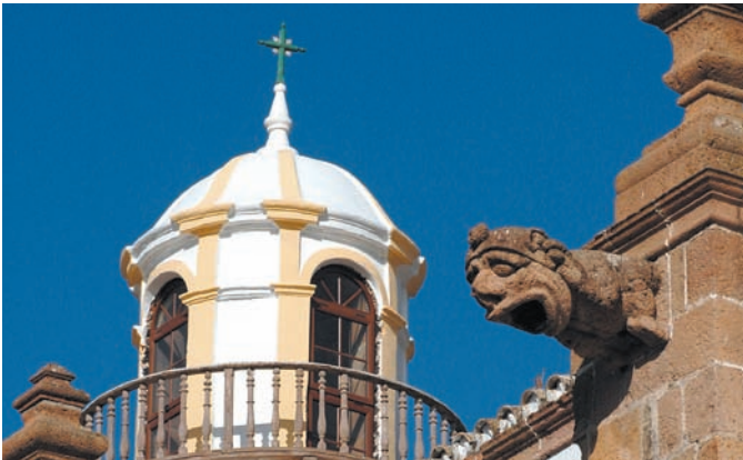
■ Detalle de la linterna
