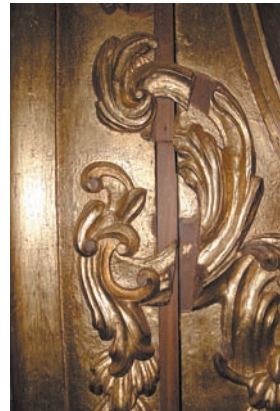
■ Desplazamiento de tablas y su saneado con tiras de madera
