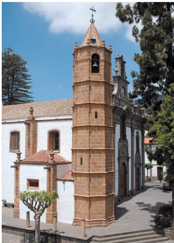
■ Vista general de la "torre amarilla"
