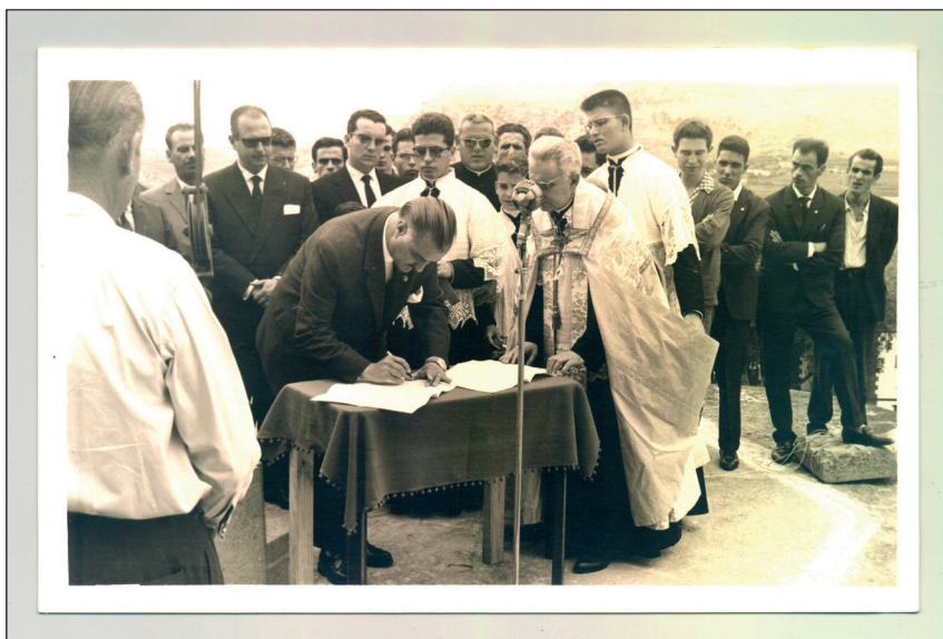
Firma del Alcalde Francisco Ferrera Rosales en el acto de colocación de la primera piedra de la última torre del templo parroquial de San Juan Bautista de Arucas, c. 1962. Fotografía original localizada en los fondos del Archivo Municipal de Arucas. Se desconoce el fotógrafo.
