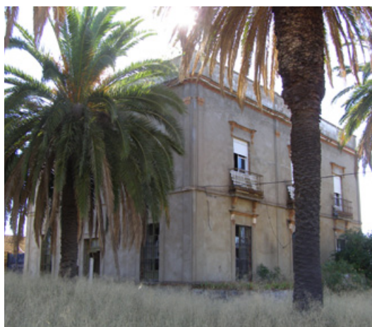
Figura 2. Rehabilitación de la antigua Casa de Dirección en el poblado minero de Cueva de La Mora
