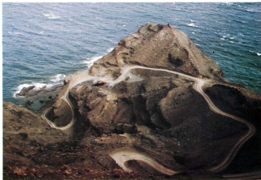
Algunas pistas constituyen impactos de primer orden que contribuyen a acelerar la erosión y degradación subsiguiente. El Risco, Agaete.
