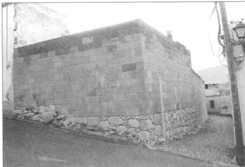
FOTO 16.—Vista final del cerramiento sur en la esquina de las calles Cueva Pintada y Bentejuí.
