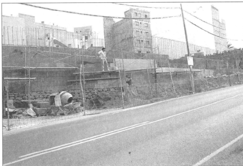
FOTO 15.—Labores de construcción de la muralla, c/ Bajada de las Guayarminas.
