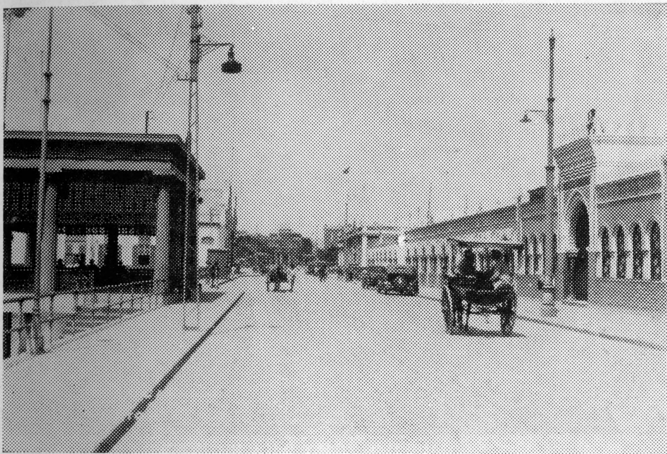
Pabellón para Oficinas en el Muelle de Santa Catalina y la Marquesina año 1926.
