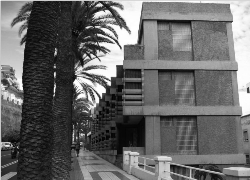
Edificio de apartamentos en la calles Paseo de Chil, 20, y Luis de la Cruz. Vista de conjunto con el desnivel entre las dos calles.
