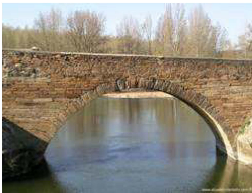
Figura 16. Puente Viejo sobre el río Génave (Jaén).
