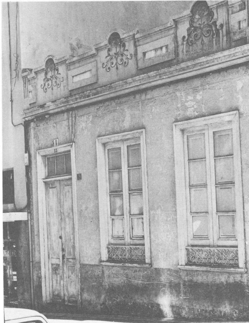
Vivienda para «El Progreso» proyectada por Antonio Pintor en la c/ Ramón y Cajal. Santa Cruz de Tenerife. Foto Alejandro Delgado.
