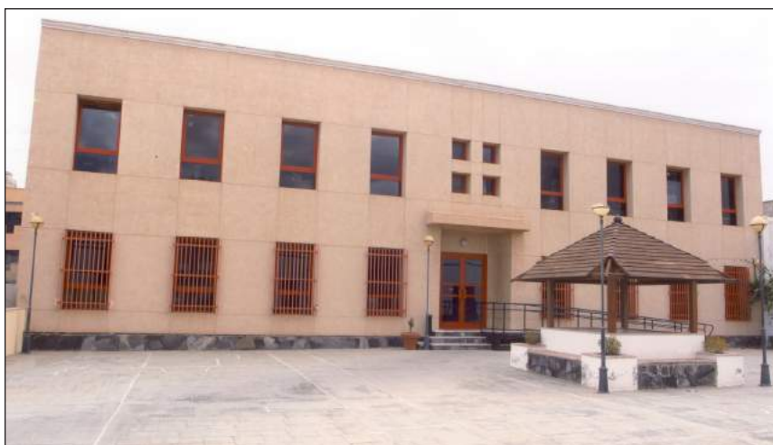
Fachada trasera. Patio del cabildo insular.
