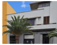
CASA DE J. HERNÁNDEZ [1931-1932] Calle Bravo Murillo 36 ARQUITECTO: Miguel Martín
