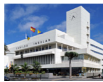
CABILDO INSULAR DE GRAN CANARIA [1932-1938] Calles Bravo Murillo 23 y Pérez Galdós ARQUITECTO: Miguel Martín
