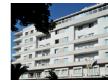
EDIFICIO DE VIVIENDAS Y HOTEL PARQUE [1931-1940] Calles Muelle de Las Palmas 2 - 4, Alonso Alvarado y Venegas ARQUITECTO: Miguel Martín
