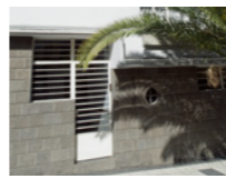
CASA GALBÁN [1932] Calle Bravo Murillo 32 ARQUITECTO: Miguel Martín
