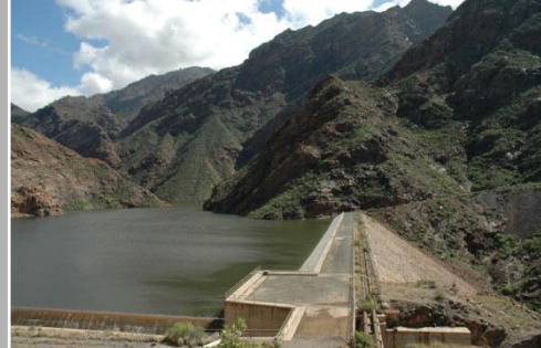
FOTOGRAFÍAS DE PRESAS DE GRAN CANARIA. ARRIBA IZQUIERDA: PRESA CAIDERO DE LA NIÑA, DE HORMIGÓN CON PLANTA RECTA (GRAVEDAD). ARRIBA DERECHA: PRESA DE PINTO (ARUCAS), DE MAMPOSTERÍA Y SILLARES (ARCO-GRAVEDAD). ABAJO IZQUIERDA: PRESA DE SORIA DE HORMIGÓN (BÓVEDA). ABAJO DERECHA: PRESA DE SIBERIO, ESCOLLERA (GRAVEDAD) CON PANTALLA ASFÁLTICA INTERIOR.
