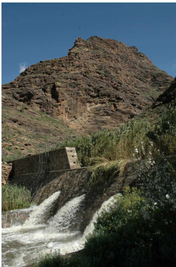
AZUD DE CONTENCIÓN, EN LA CUENCA DE ARTENARA-TEJEDA (GRAN CANARIA), PARA CONTENER LA EROSIÓN Y CONFORMAR NATEROS.
