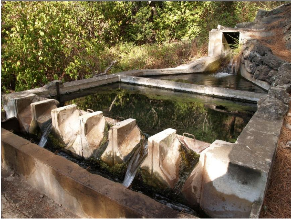
MODELOS DIFERENTES DE MEDIDORES DEL AGUA ARRIBA: AFORÍMETRO DEL AGUA EN TENERIFE EN OBRA DE FÁBRICA (FCO. M. HERNÁNDEZ MARTÍN). ABAJO: CANTONERAS DE ARUCAS-FIRGAS, EN CANTERÍA NOBLE
