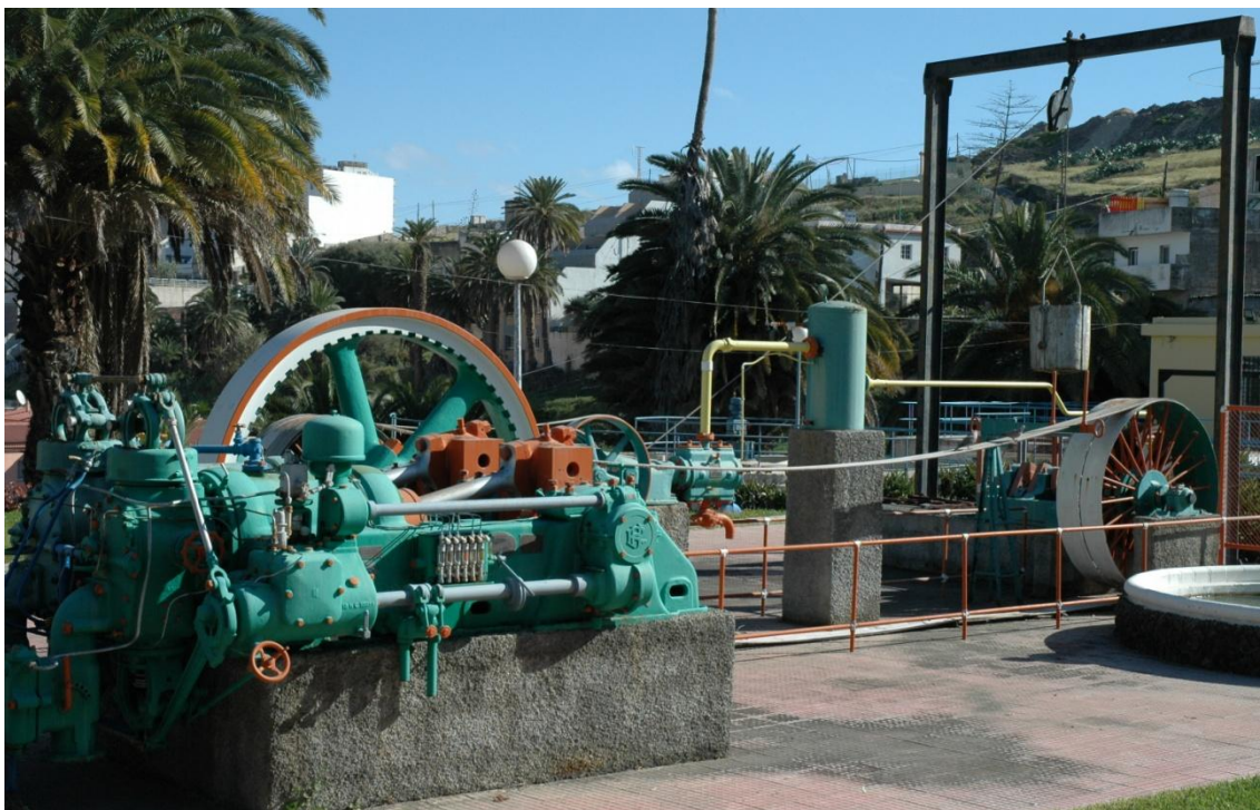
ESTACIÓN MUNICIPAL DE AGUAS DE ALMATRICHE (GRAN CANARIA), DONDE SE EXPONE UN POTENTE MOTOR RUSTON Y TODO EL SISTEMA DE ELEVACIÓN DE AGUAS ANTIGUO. DESALADORAS, DEPURADORAS, ESTACIONES DE BOMBEO... SON EXCELENTES RECURSOS PARA LOS ESTUDIOS UNIVERSITARIOS DE LOS TEMAS RELACIONADOS CON EL AGUA EN CANARIAS.
