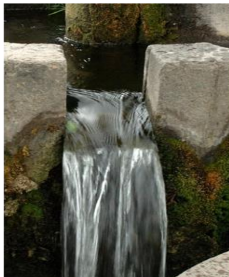
CHORRO DE AGUA DE UNA AZADA DE 9-10 LITROS POR SEGUNDO, SALIENDO POR LA TRONERA DE UNA CANTONERA (ARUCAS, GRAN CANARIA).
