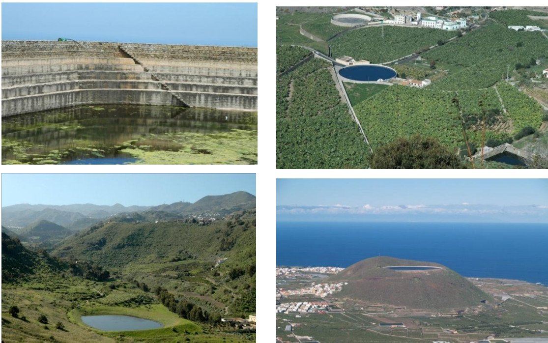
ARRIBA IZQUIERDA: MARETA O ESTANQUE DE GRAN CAPACIDAD. ARRIBA DERECHA: ESTANQUE REDONDO DEL NORTE DE LAS ISLAS HÚMEDAS (GRAN CANARIA, TENERIFE Y LA PALMA). ABAJO IZQUIERDA: ESTANQUE DE BARRO O MASAPÉS (NORTE DE GRAN CANARIA). ABAJO DERECHA: CHARCA MODERNA SOBRE UN CONO VOLCÁNICO (NORTE DE TENERIFE).
