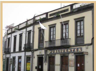
El Real Casino, edificio de 1926
