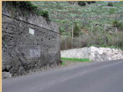
Continuación del camino de regreso al punto inicial
