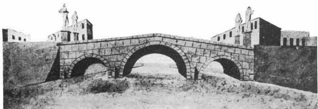
Puente de la Ciudad de las Palmas construido á expensas del Alto Sr. Obispo D. no Manuel Verdugo y Albitarría en 1516.
