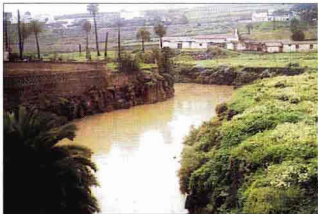
Presa de Tamaraceite. 1987
