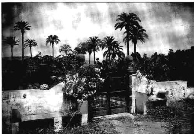
Entrada a la casa de D. José Rivero.
