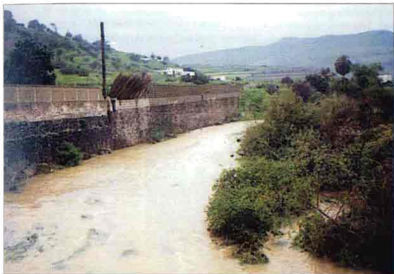
Cauce del Barranco.
