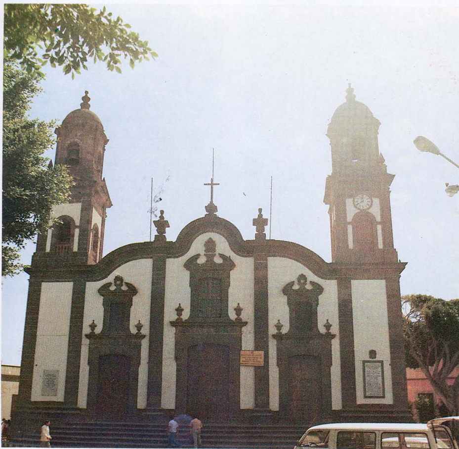
Fachada del templo
