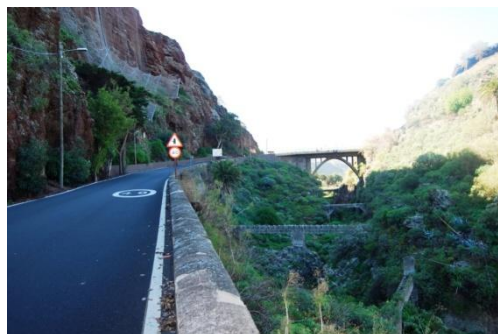
AYER (1833, GRABADO DE WILLIAMS) Y HOY DE LA ANGOSTURA EN LA ENCONADA DEL PUENTE DE LA CALZADA.
