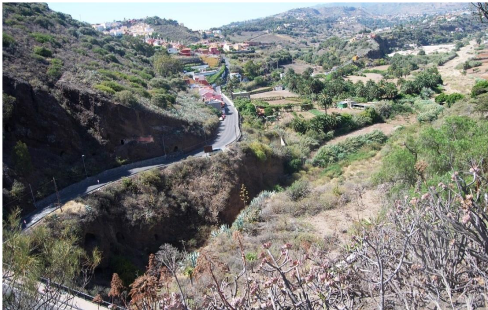
PANORÁMICA DEL BARRANCO DE LA ANGOSTURA A PARTIR DEL PUENTE ACTUAL (FOTO: PEDRO SOCORRO).
