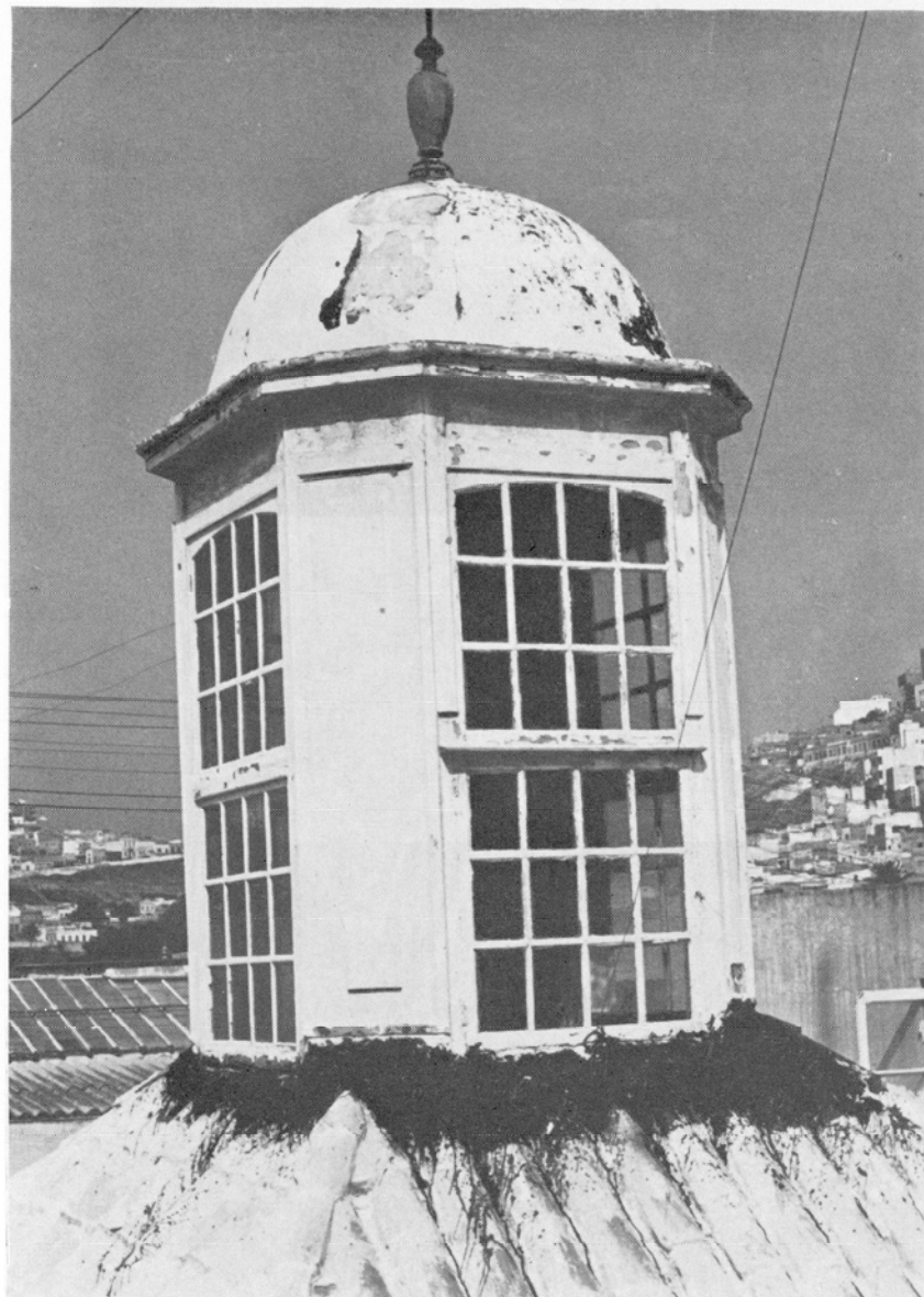
13. Linterna de la escalera principal
