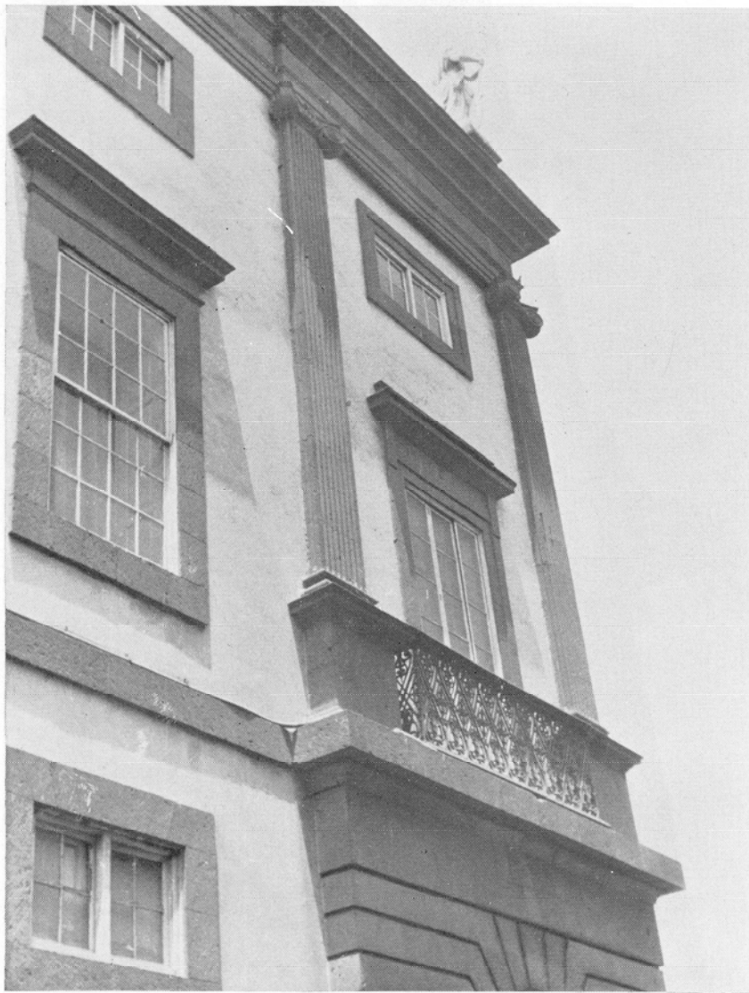
7. Fachada lateral a la calle Castillo
