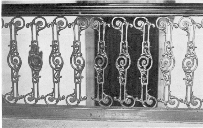
14. Balaustres de la escalera principal
