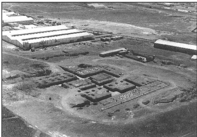
Construcción del Hospital General.
