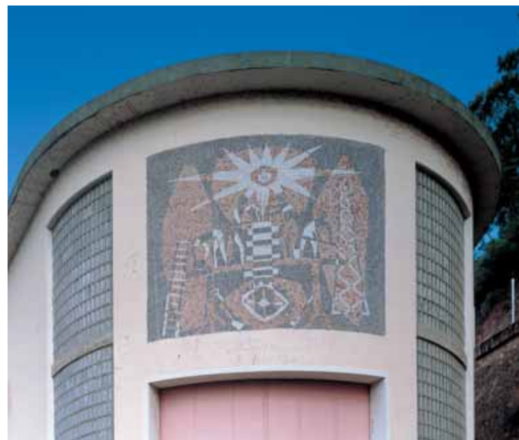
Mural situado en el edificio de la sala de máquinas de la central hidráulica de Puerto Peña, pantano de Cijara, Badajoz, 1956.
