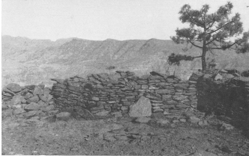
3.—Muro de separación entre el cuerpo central y el de la derecha, visto desde el interior del cuerpo central.
