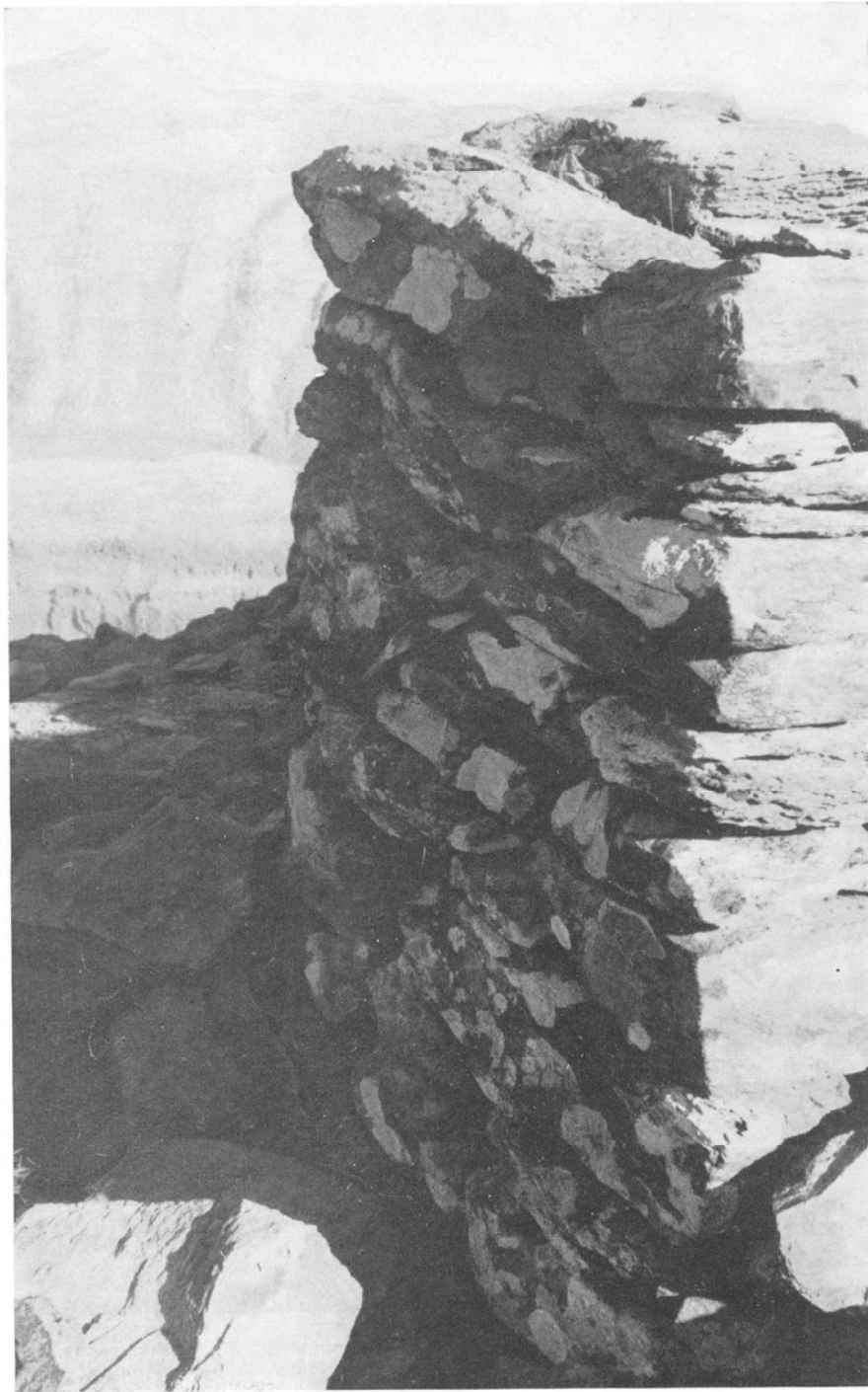
8.—Esquina exterior del muro Este del cuerpo abierto. Obsérvese la notable realización.
