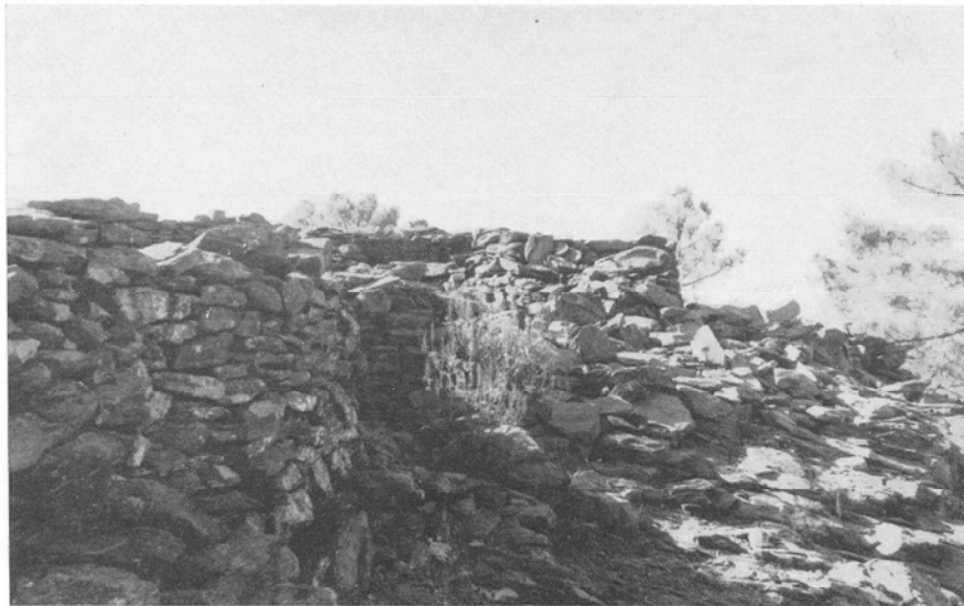
4.—Encuentro entre el muro Norte del cuerpo de la derecha (en primer plano) y el muro exterior Norte del cuerpo central, sobre el borde de la ladera que limita al monumento por el Nordeste.
