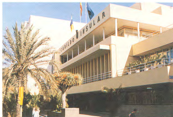
Edificio racionalista del Cabildo Insular de Gran Canaria
