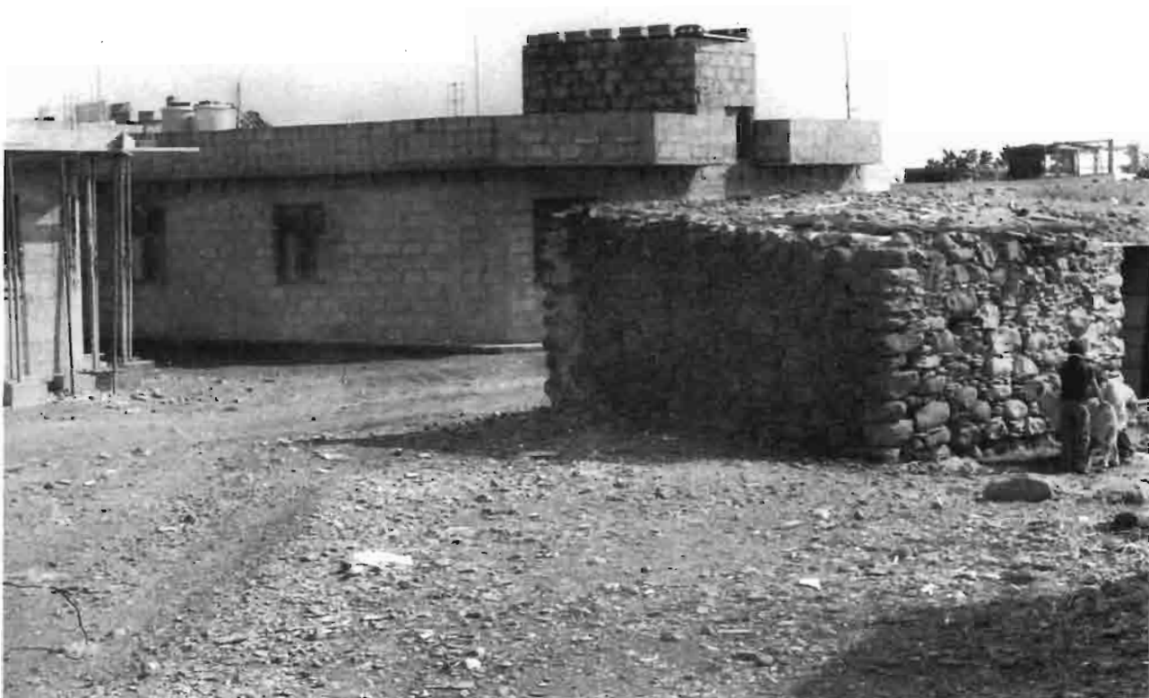
12.— Construcción dedicada a corral situada en pleno centro de la urbanización.
