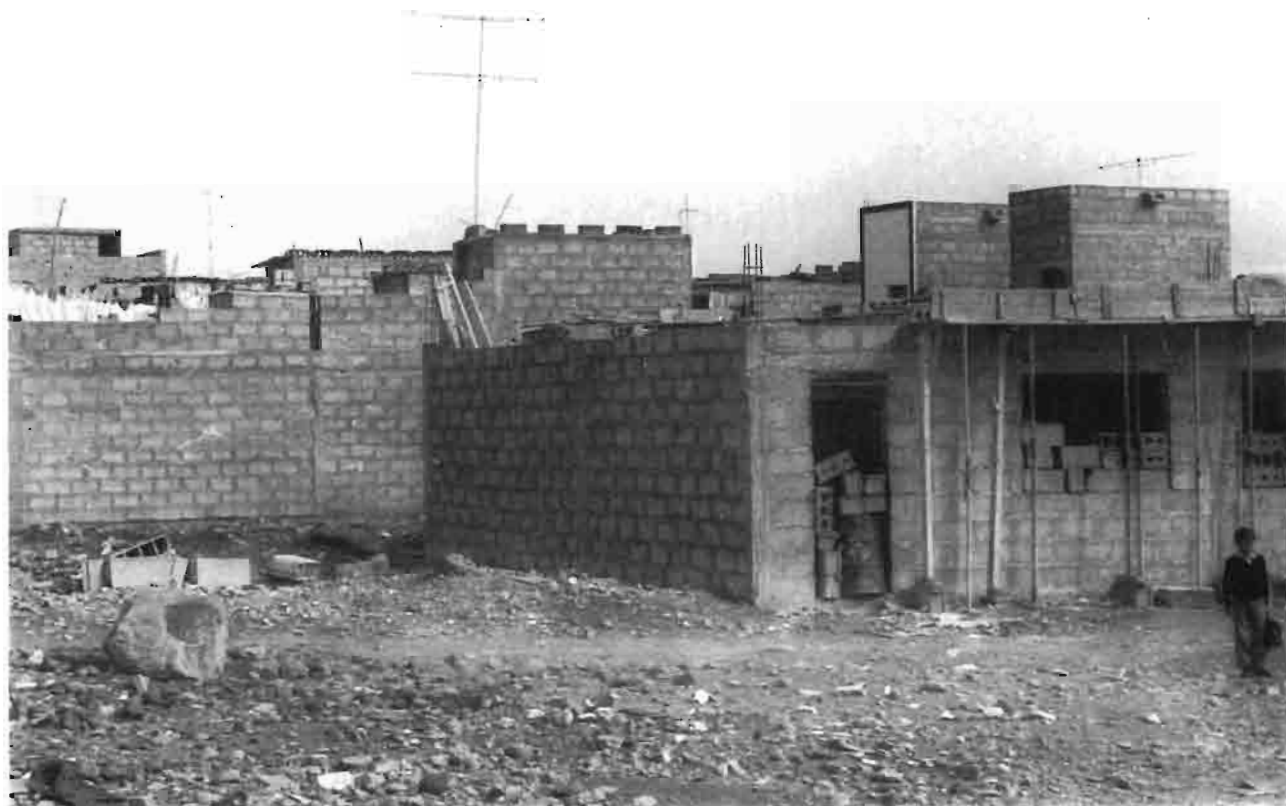
16.— Viviendas de autoconstrucción.
