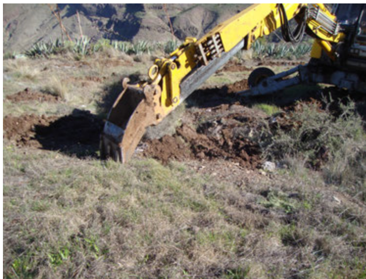
Imagen 3: Realización de banqueta con la retroaraña
