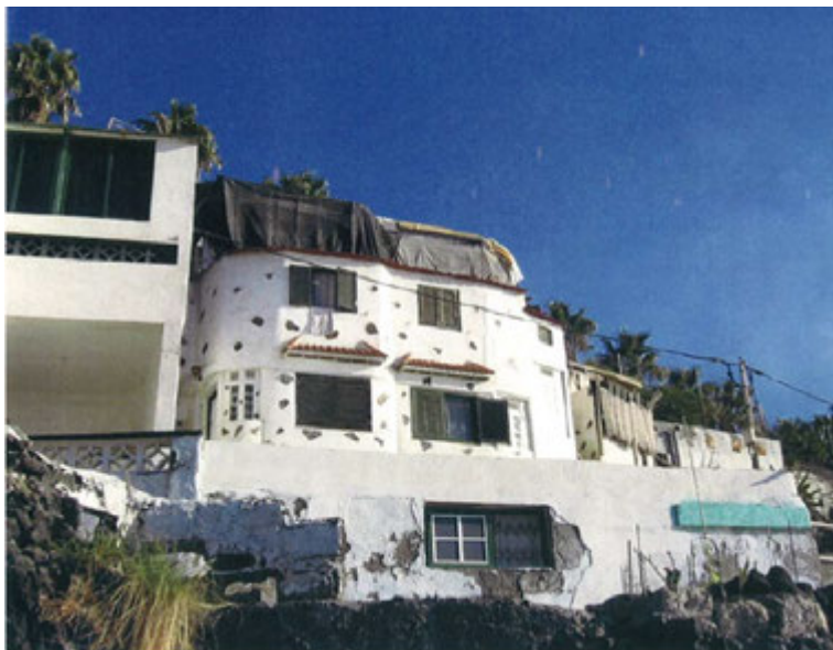
Figura 6.3: Fachadas de viviendas.
