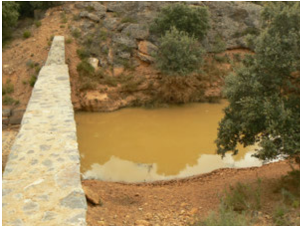
Figura 11.17: Embalse de agua retenido por un dique de mampostería hidráulica, semanas después de la tormenta (corrección de la rambla de San Lázaro, Cetina, Zaragoza) (Foto: M.I. Ureta).
