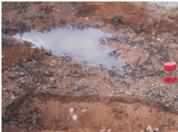
Figura 4.12: Anegamiento superficial por disminución de la infiltración de agua en un suelo compactado.
