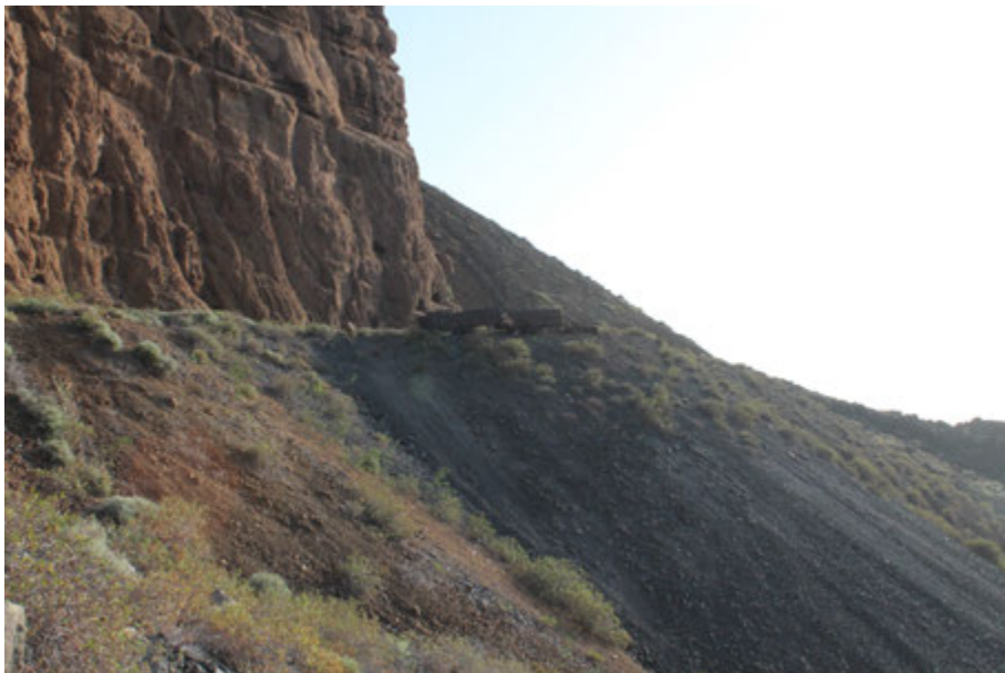
Figura 1.9: Escombrera procedente de una explotación minera en el Hierro.
