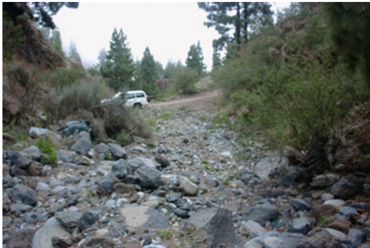
Figura 5.1: Cauce del barranco aguas arriba del pontón.
