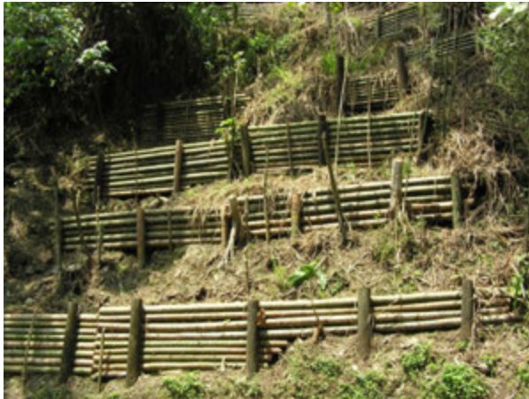
Figura 4.20: Control de movimientos en masa mediante barreras vegetales.
