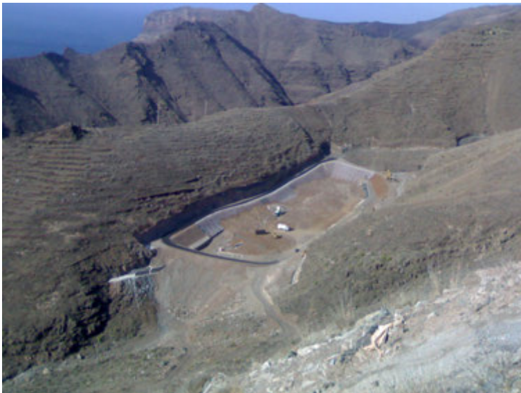
Figura 1.6: Ampliación del vertedero de La Gomera.
