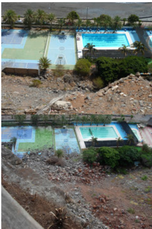
Figura 15.2: Imagen del deslizamiento en el acantilado del Parador de Turismo de La Gomera.
