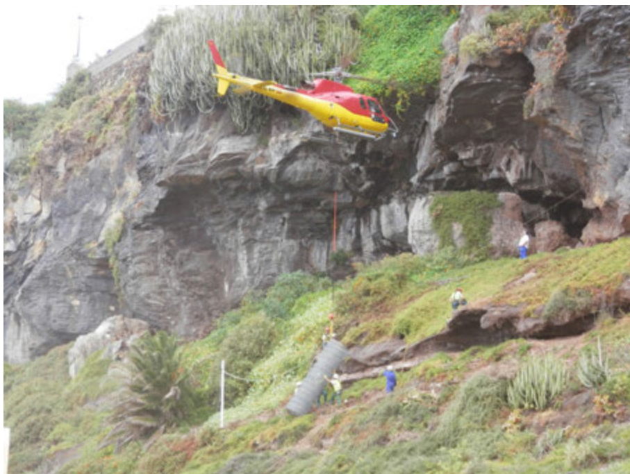
Figura 15.4: Colocación de la malla mediante helicóptero.
