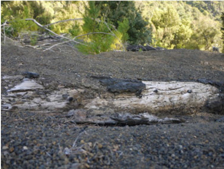
Figura 3.8: parte superior de una empalizada, colmatada aguas arriba y abajo tras 7 años (2014).
