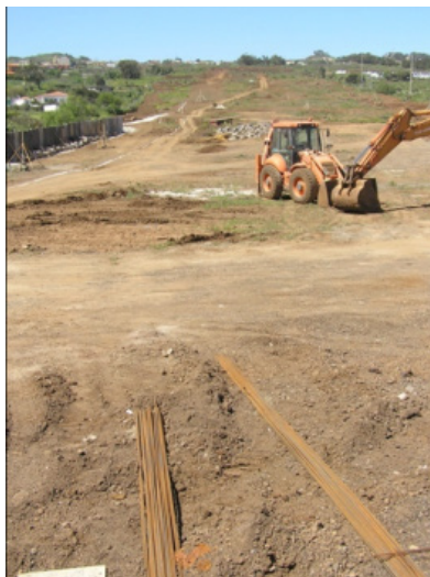
Figura 4.2: Utilización de maquinaria pesada en los suelos de La Laguna.
