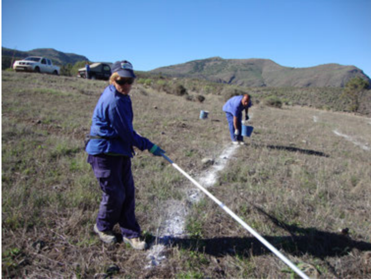
Imagen 1: Marcaje de las banquetas de 5 metros para la retroaraña.
