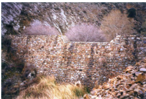
Figura 11.23: Un dique de mampostería hidráulica que use los materiales propios de la zona, constituye un elemento construido según la arquitectura rural tradicional y se integra de manera excelente en el paisaje. (Foto: I. Pérez-Soba).
