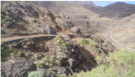
Figura 14.9: Acceso a San Lorenzo. Hermigüa.
