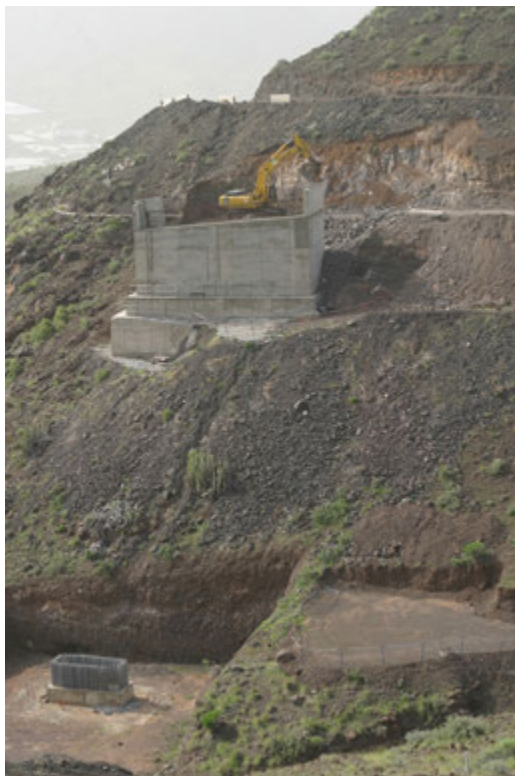
Figura 5.1: Construcción de un viaducto en nueva carretera.
