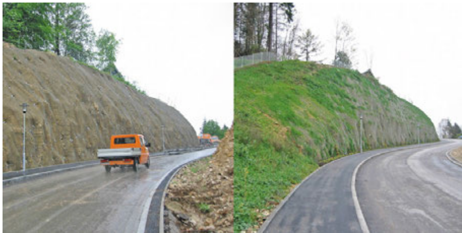
Figura 8.4: Estabilización de taludes mediante revegetación (Fuente: www.geobrugg.com ).
