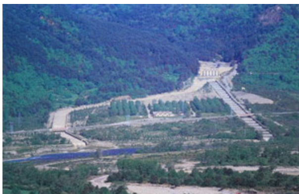
Figura 11.31: Torrente de Arás (Biescas, Huesca): en las obras tras la catastrófica avenida de 1996, se construyó un cauce curvo que pasó a ser el ordinario, dejando como alternativo el antiguo encauzamiento rectilíneo del torrente en el cono de deyección (Nicolás, 2001: 184).
