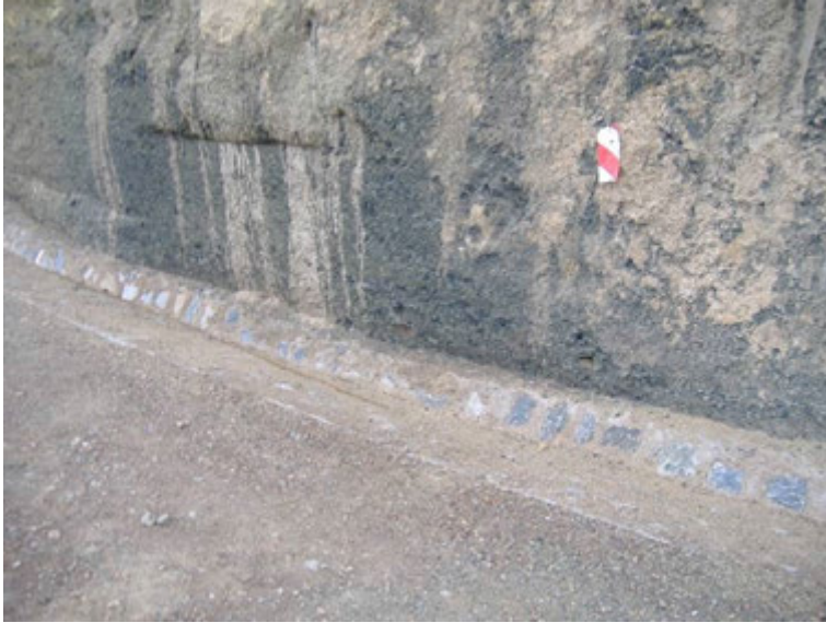
Figura 5.12: Detalle de cuneta acabada en piedra.
