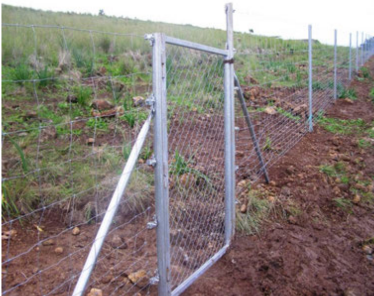
Figura 1.4: Vallado perimetral con puerta de acceso a recinto repoblado.
