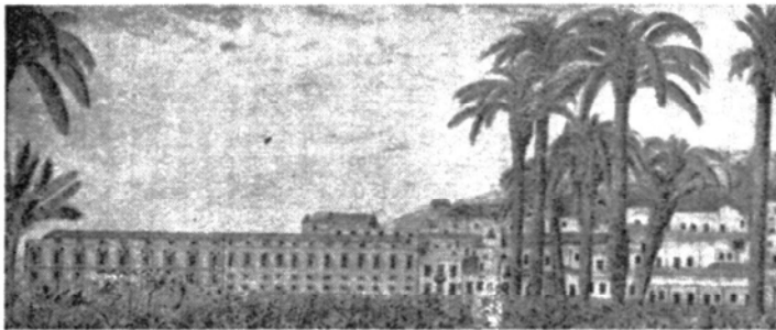
Vista exterior del Hospital y Hospicio.
