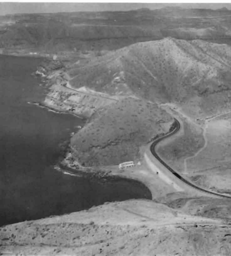
Carreteras del Ministerio de Obras Públicas
