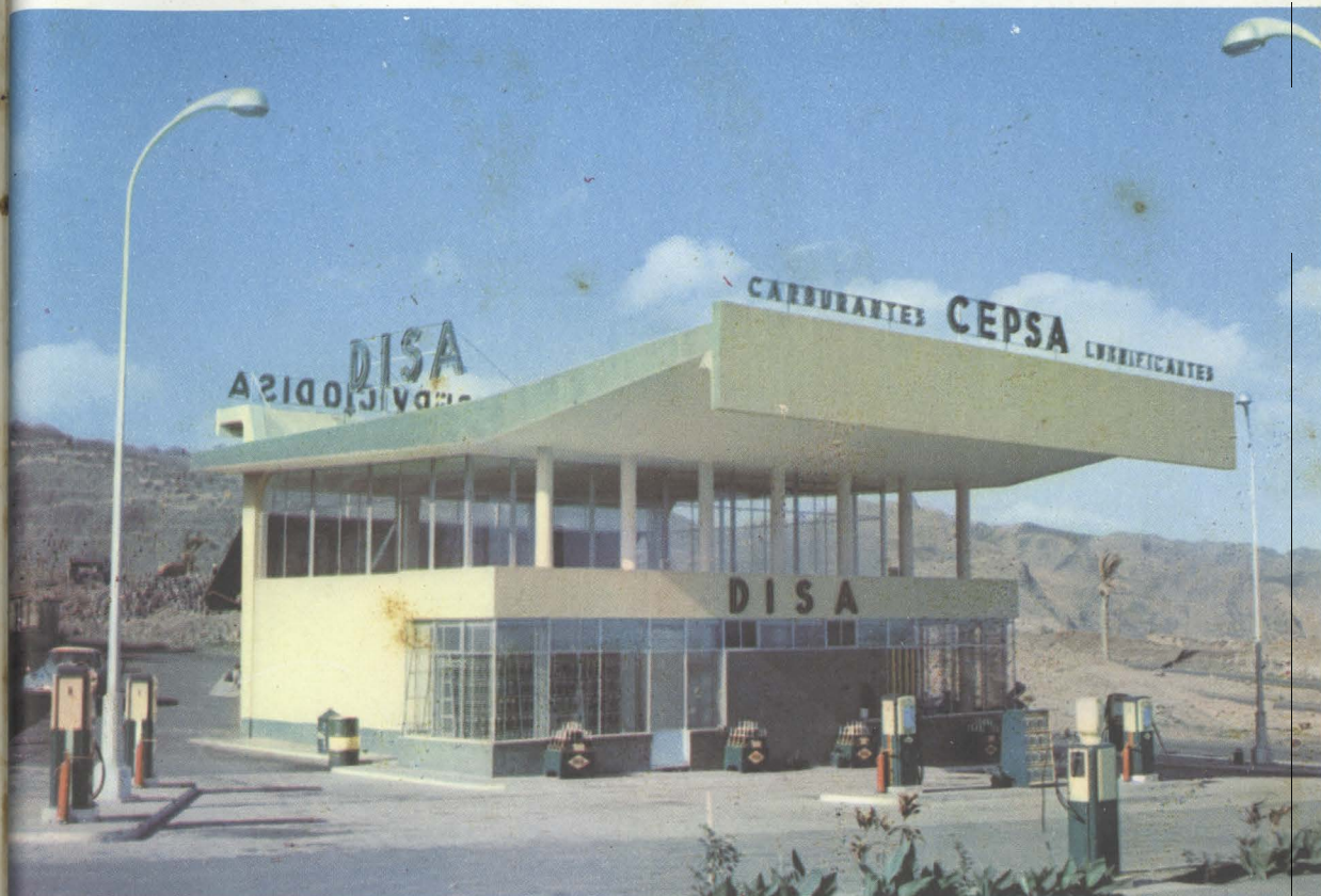
ESTACION DE SUMINISTRO, RECIENTEMENTE INAUGURADA, EN LA AVENIDA 3 DE MAYO.
