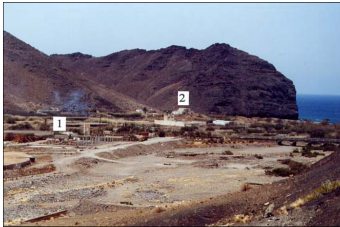
COMIENZO DEL PROYECTO COMÚN DE DESALACIÓN DE LA ALDEA (MAYO DE 2000). EN PRIMER PLANO LAS OBRAS INICIADAS DE PLANTA DESALADORA. AL FONDO (2) EL EDIFICIO DE LA PRIMERA DESALADORA POR COMPRESIÓN A VAPOR (1976).
