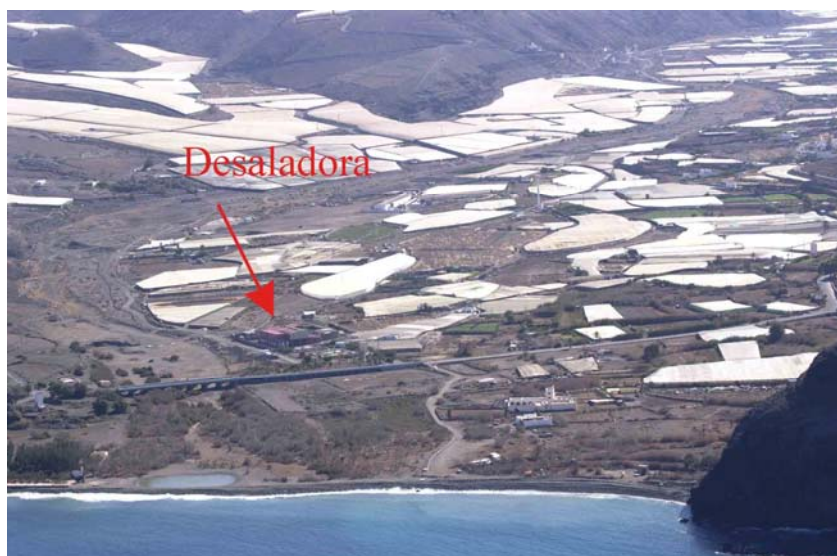
DESEMBOCADURA DEL BARRANCO DE LA ALDEA, LOCALIZACIÓN DE LA DESALADORA DE LA MARCIEGA, 2005
