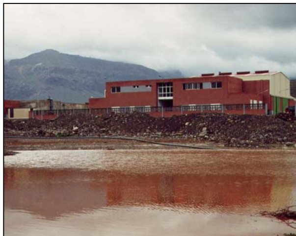
EFFECTOS DE LA RIADA DE 23 DE DICIEMBRE DE 2001. EL BARRANCO UNTO A LA DESALADORA CON EL CAUDAL DISMINUIDO.
