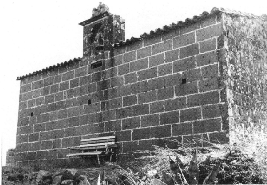
Lámina 7: Vista exterior del testero de la ermita.
