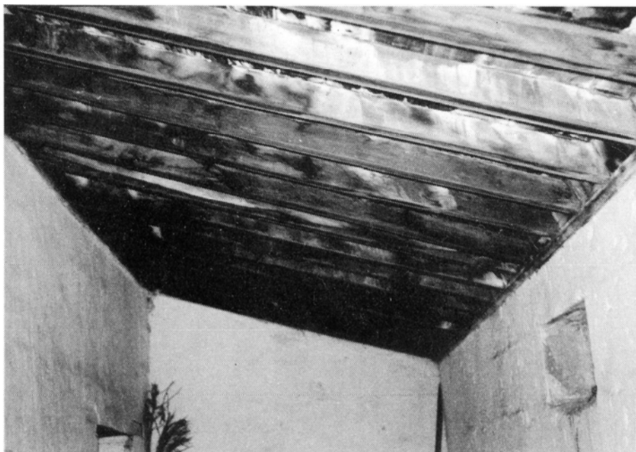
Lámina 8: Cubierta interior de la sacristía.
