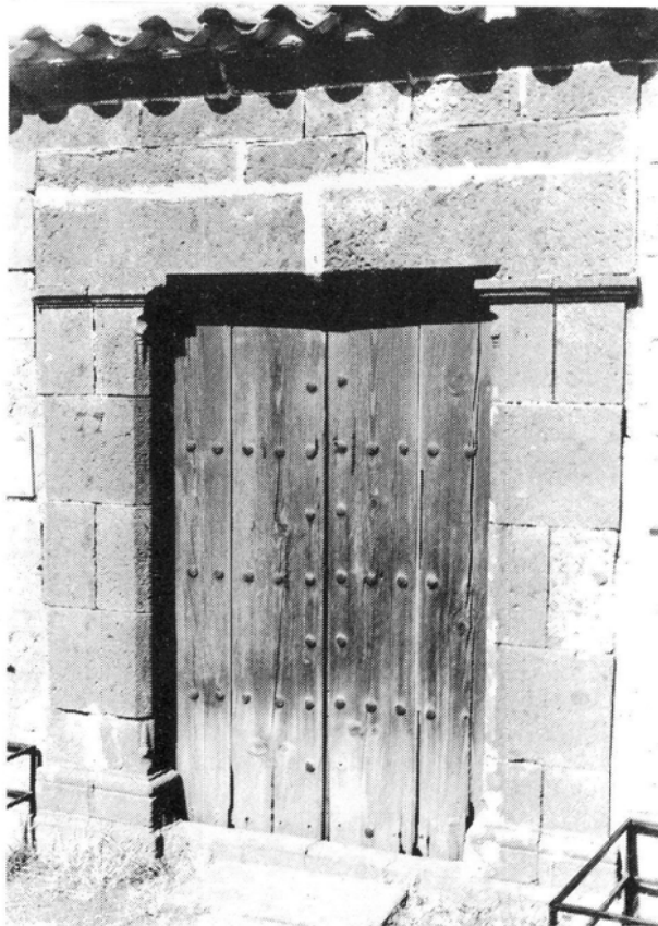
Lámina 3: Acceso a la nave desde el exterior. Muro occidental.
