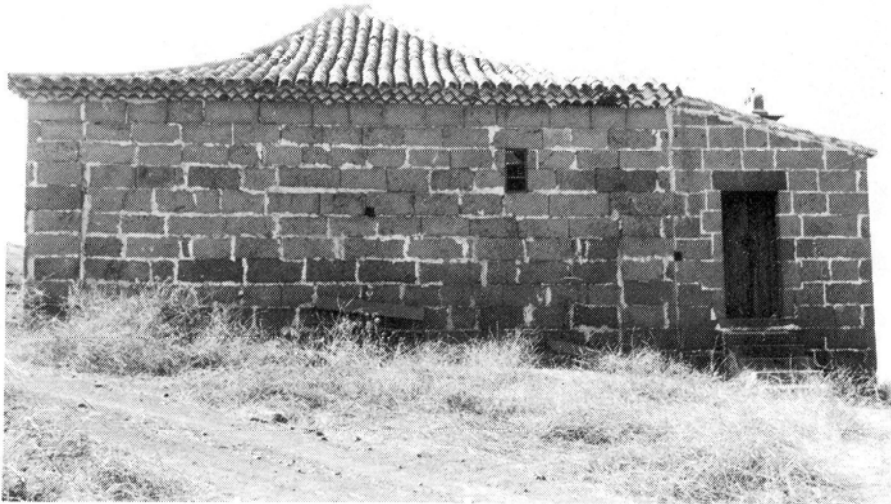
Lámina 2: Vista exterior del costado sur.
