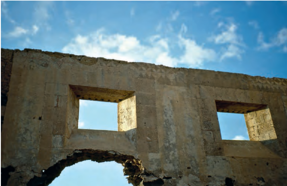
Casa Fuerte. Decoración de esgrafiados del interior de la cocina. Adeje
