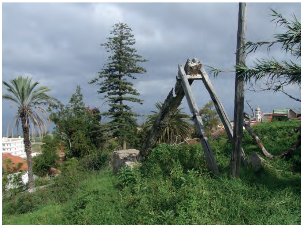
Canalizaciones de madera. Hacienda de los Príncipes. Realejo Bajo
