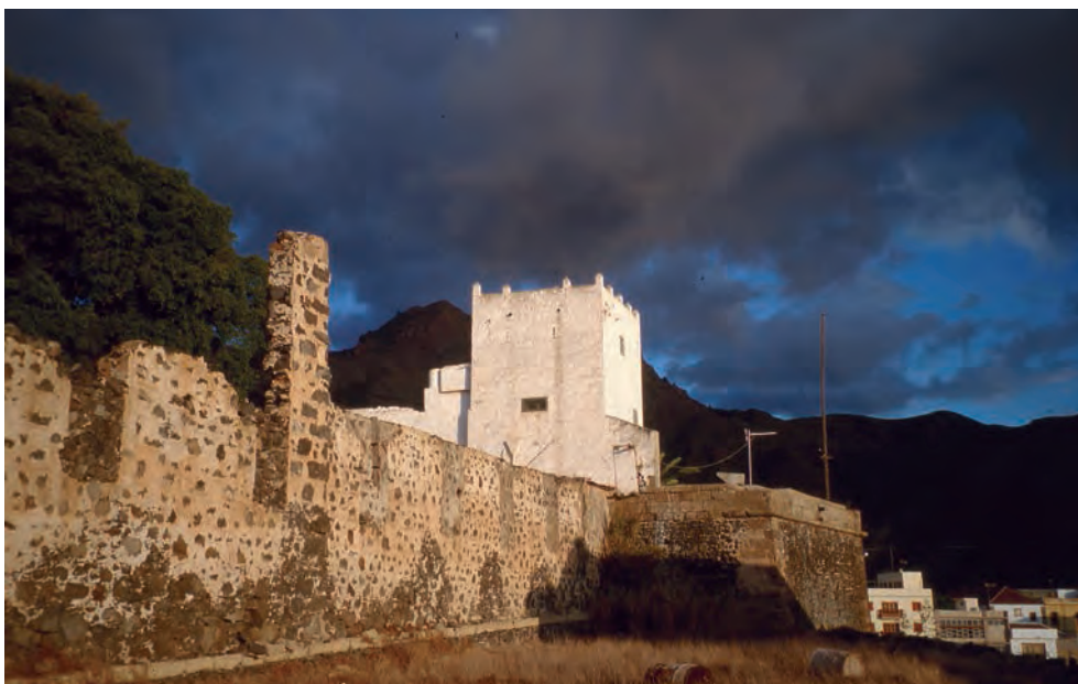
Casa Fuerte. Torre de homenaje y baluarte. Adeje
