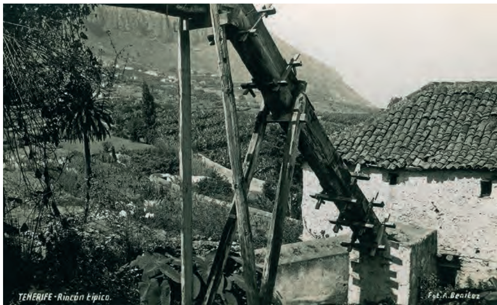
Canalizaciones de madera y molino de Abajo. Hacienda de los Príncipes. Realejo Bajo
