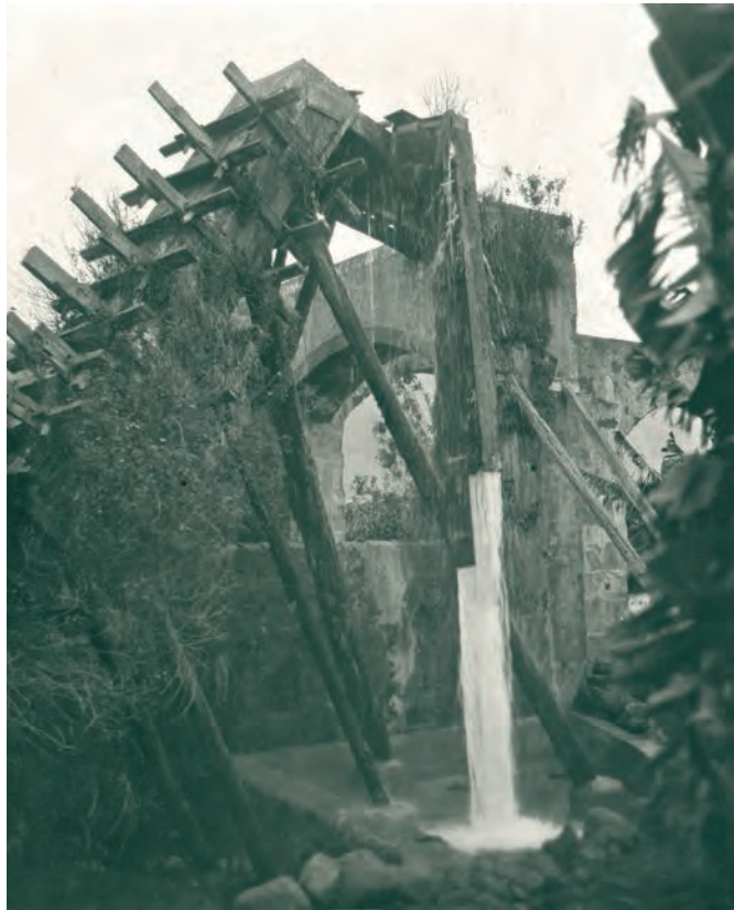
Acueducto del molino Nuevo y canalización de madera. Argual
