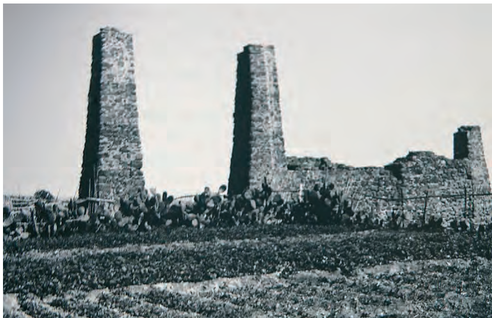
Los Picachos, vestigios del acueducto del ingenio de Los Llanos de Jaraquemada. Telde
