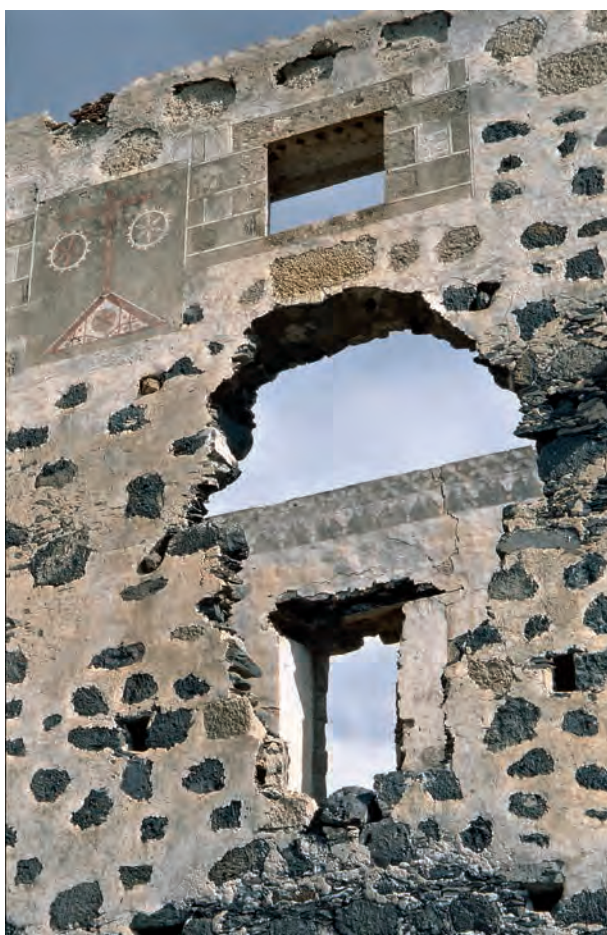
Casa Fuerte. Decoración de esgrafados de la cocina. Adeje
