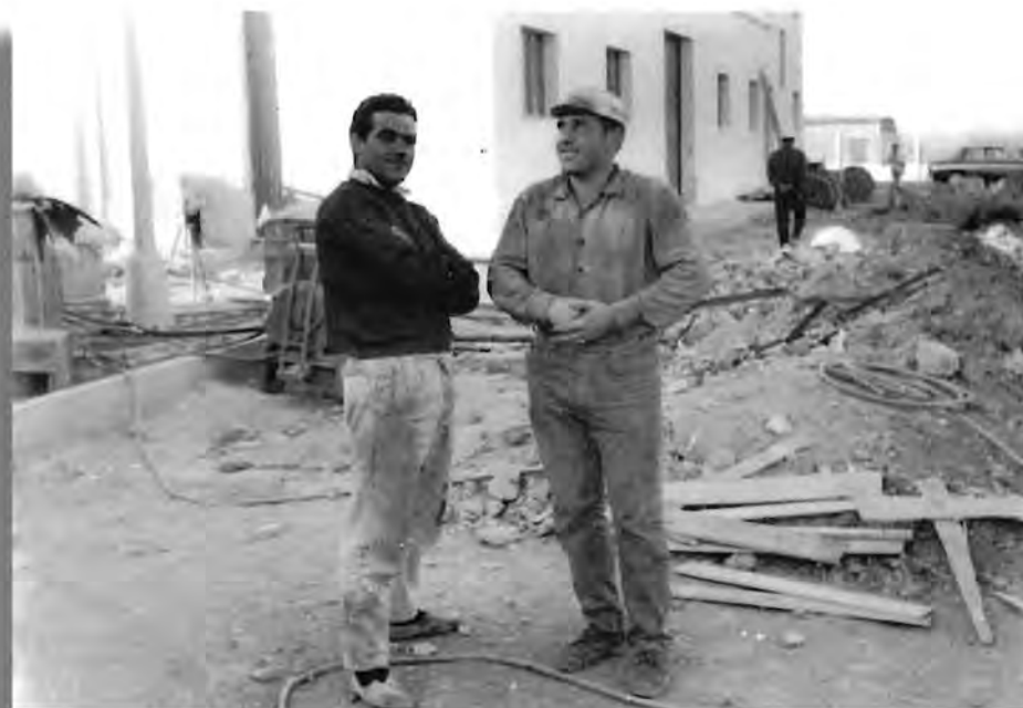
Construyendo la Potabilizadora
