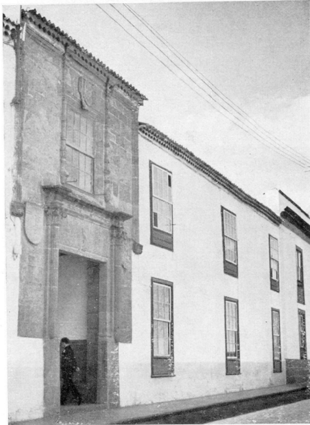
LA LAGUNA: Casa del Corregidor .—Conjunto de la portada
