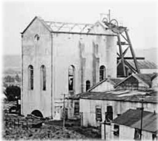
Foto 6. Bomba Cornish (Cornualles)
