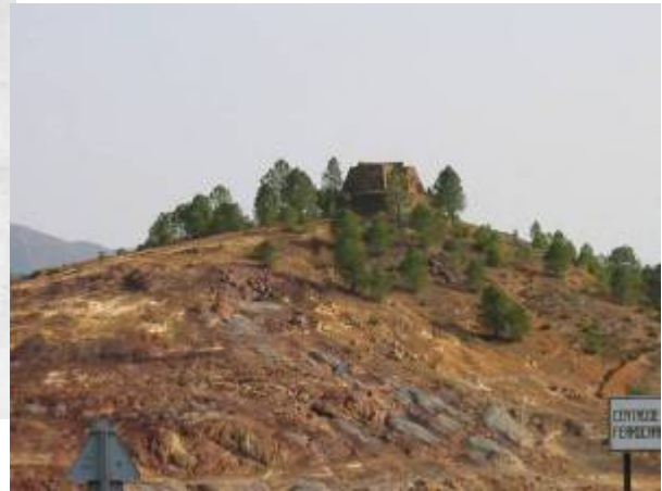
Foto 7. Restos Bomba Cornish (2002) (E.Romero)
