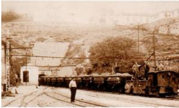
Foto 13. Locomotora saliendo del túnel Naya (Archivo F.R.T.)
