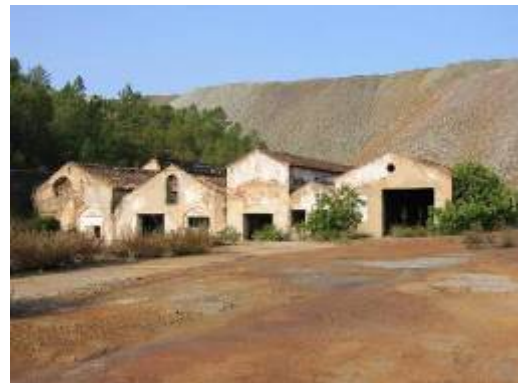
Foto 4. Almacén Mina (E. Romero)
