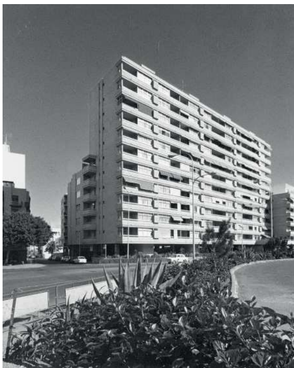
Edificio Obelisco fotografía de M. Roca Suárez.
