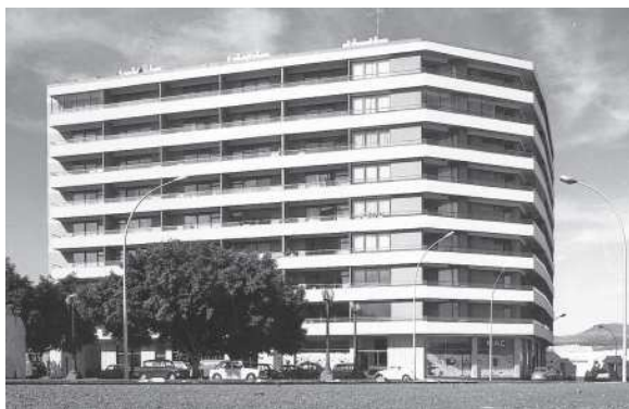
Fotografía de edificio Roca-Prats de Fachico Rojas.
