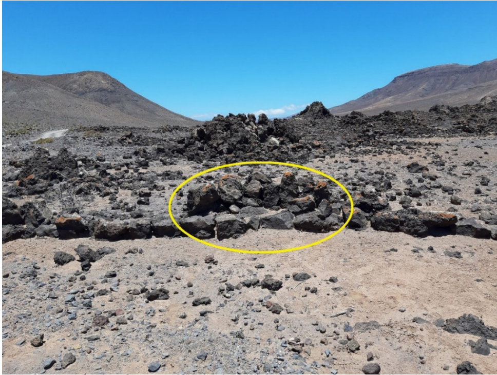
Figura 18. Obsérvese la estructura en forma de banco con respaldo, formando parte del cerramiento de la estructura E3. Foto: Carmelo J. Ojeda Cabrera (22-06-2019).
