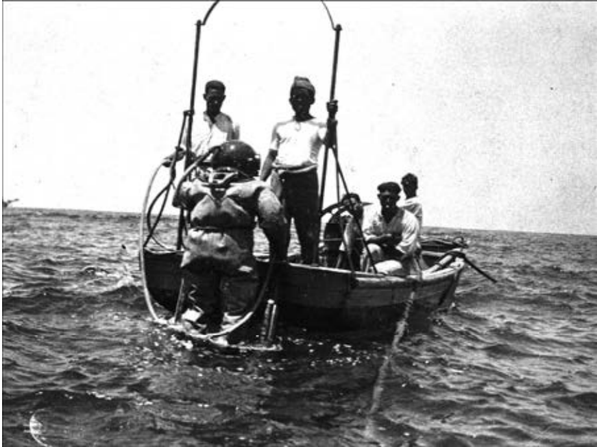
Fig. 3. Buzo con escafandra estanca utilizando la escalera de la embarcación durante las obras del embarcadero de El Penitente.
