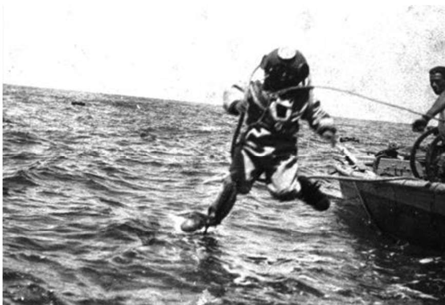
Fig. 2. Buzo con escafandra estanca salta al agua durante las obras del embarcadero de El Penitente.
