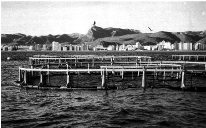
Fig. 2. Fase de engorde en acuicultura: jaulas flotantes. Las jaulas de la figura, localizadas en Melenara (Gran Canaria), son las más idóneas para el desarrollo de la acuicultura canaria.
