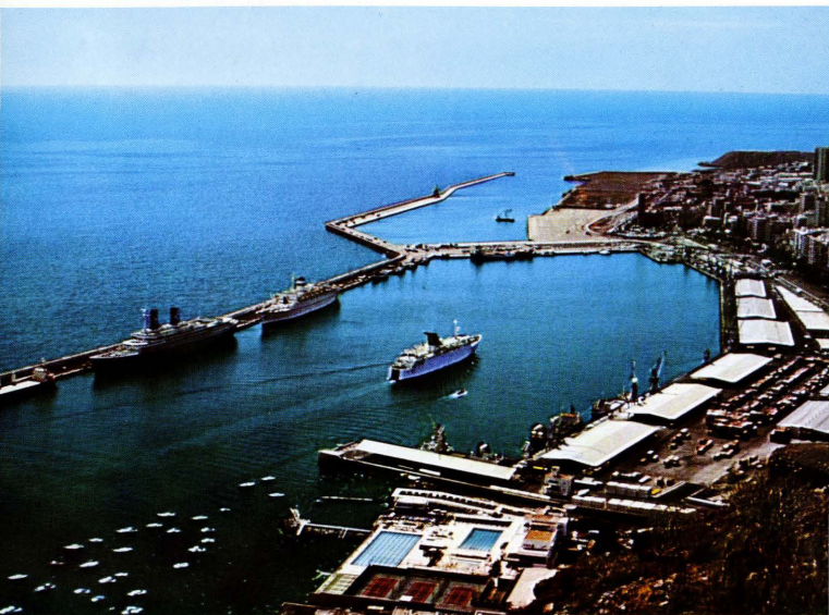
Dársena Comercial y nueva Dársena Sur
