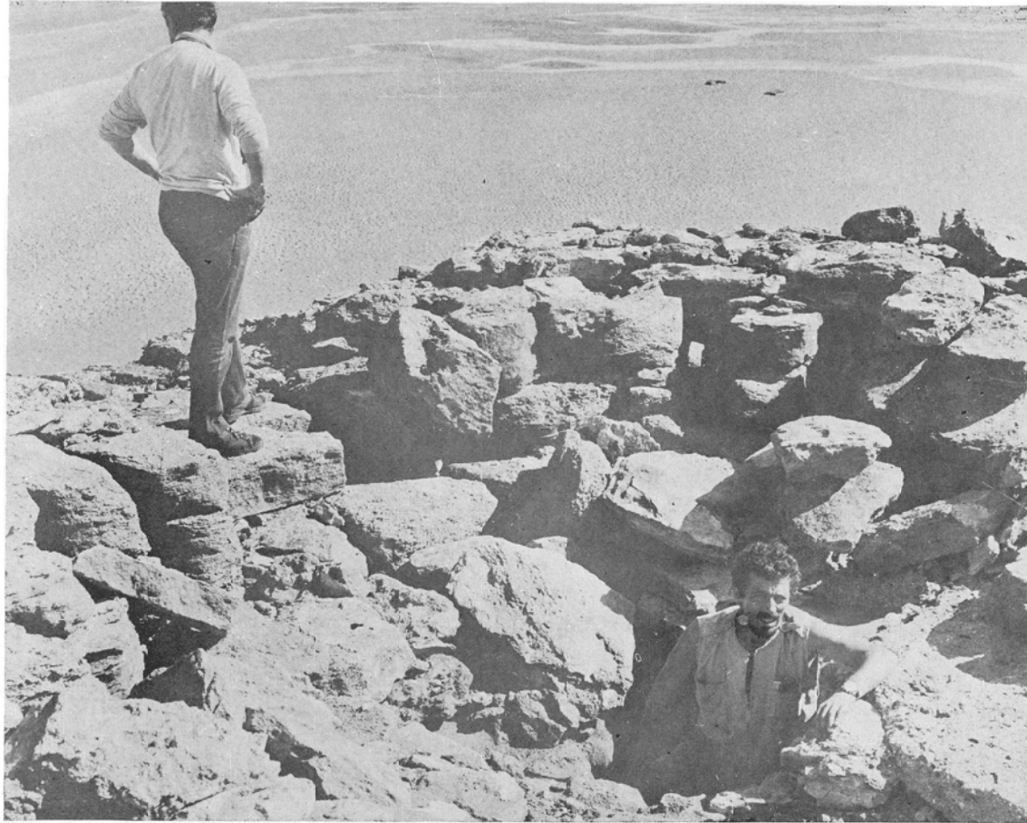
Agoutir, lagune de Khnifis (Puerto Cansado), ruine de la tour, aspect de la partie supérieure: on remarquera les ouvertures internes (supérieures) de plusieurs meurtrières et, à travers l'une d'elles, son débouché sur l'extérieur — Cliché Maximilien Bruggmann, aimablement communiqué par l'auteur.
