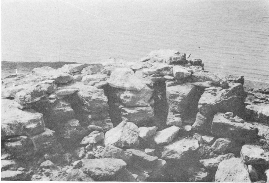
1.—Ruine de la tour de Agoutir, partie supérieure, avec les meurtrières.
