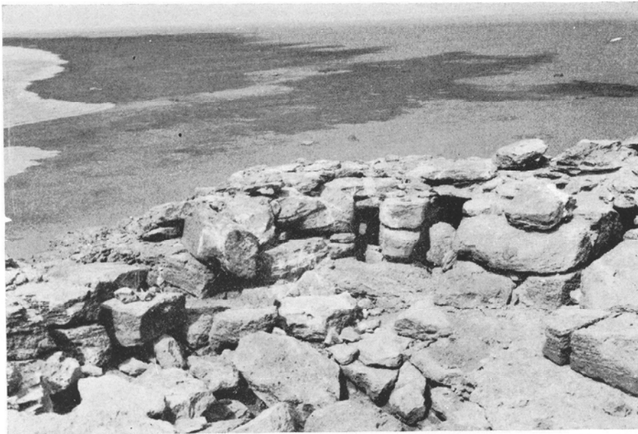
1 et 2.—Ruine de la tour Agoutir, partie supérieure, avec le départ supérieur des meurtrières: noter le plancher de mortier. — Clichés Th. Monod.
