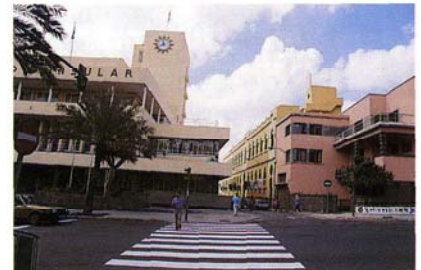
Casa Palacio Insular
