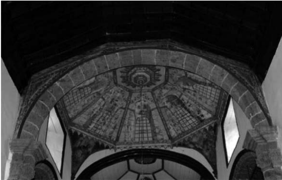
Fig. 3. Artesonado central de par y nudillo, y artesonados del antepresbiterio con decoración trompe l'oeil y del presbiterio en blanco, ambos de faldones lisos (Iglesia de Santa Catalina Mártir de Alejandría, Tacoronte)
