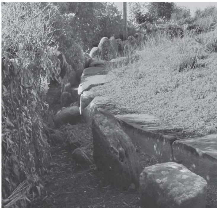
Fig 3: Enlosado junto a los monolitos que en ocasiones descansan en los sillares. Parte Sur del círculo.
