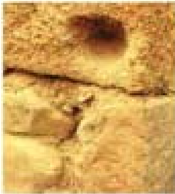
Detalle del muro pisado de una casa.
