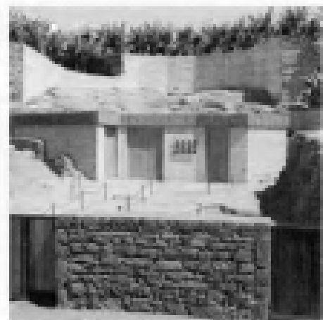
Primer cierre arquitectónico construido en 1976.
