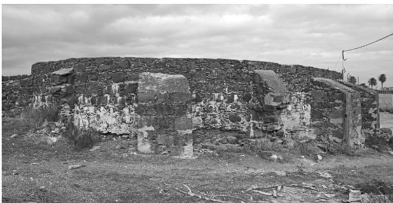
Estanque circular de pared delgada con contrafuertes
