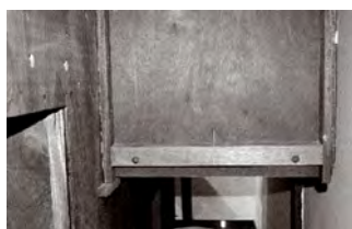
Apoyo al muro.
